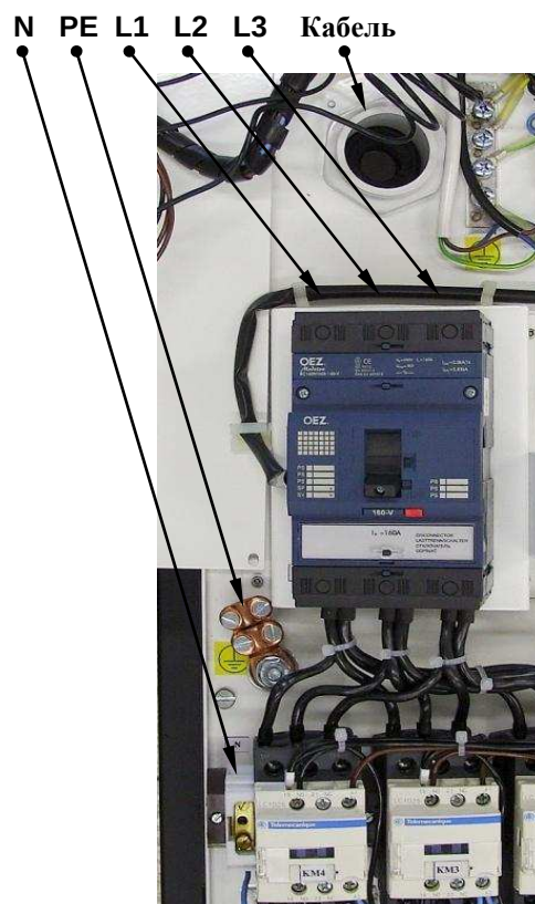
Рис. 21. Подключение входного кабеля котла «Daline PTE 22 – 60»
